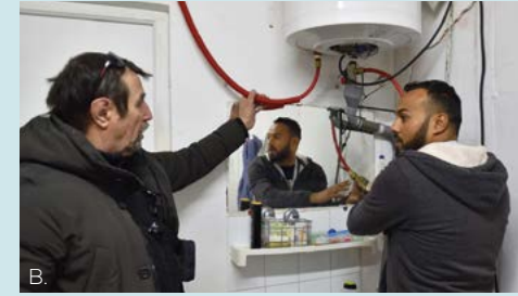
B. Patrick Desbouiges, de l'association Just, et Antun (à droite) ont installé un chauffe-eau sur l'ancien squat de la synagogue de Saint-Louis
